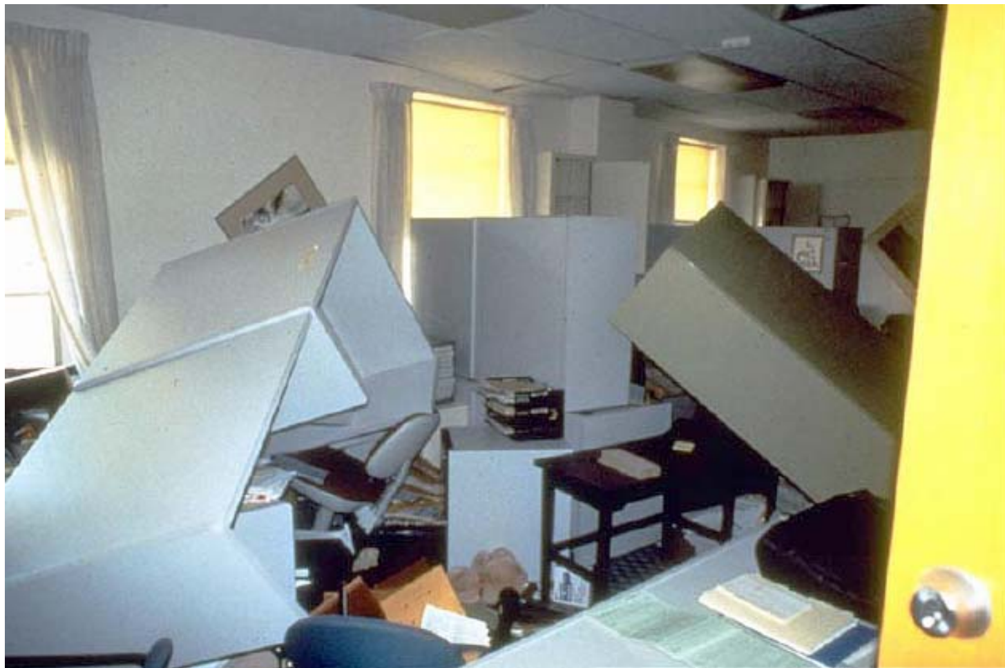
VA Sepulveda - NS Damage
